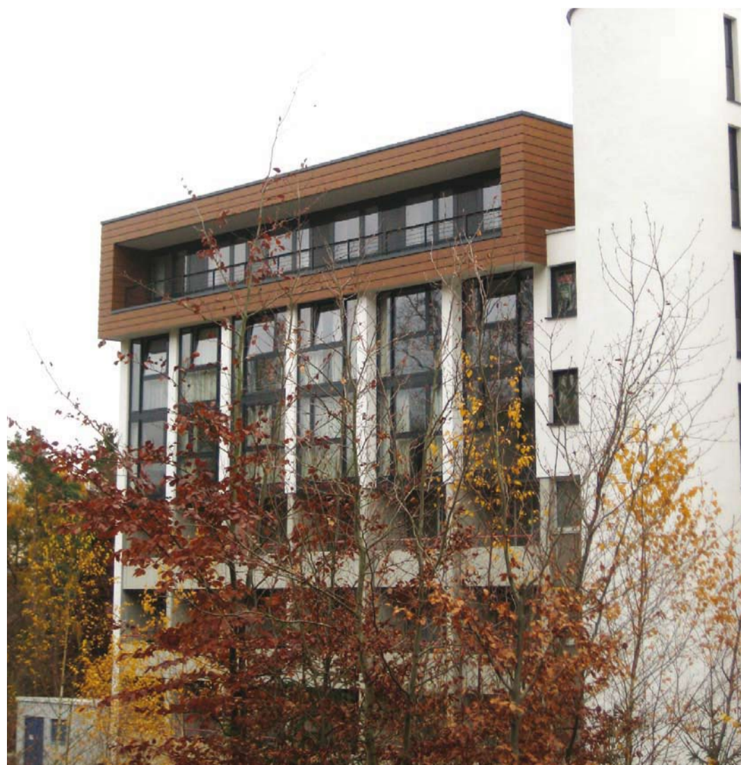
Die neugestaltete Fassade der Hainbergklinik fügt sich in die naturnahe Umgebung ein.
